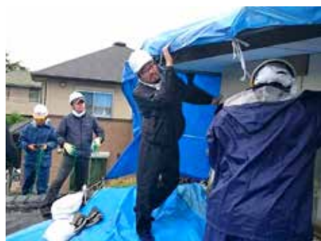
熊本地震被災地での雨漏り補修 有吉社長も自ら現場に立った これも企業コラボによるCSR活動のひとつ
